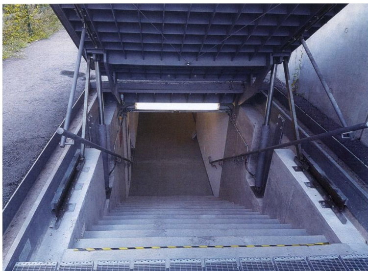
Abb. 3.4.2: Falltür {„Bodenklappe“} als Fluchttreppen-Ausgang [Beispiel]
