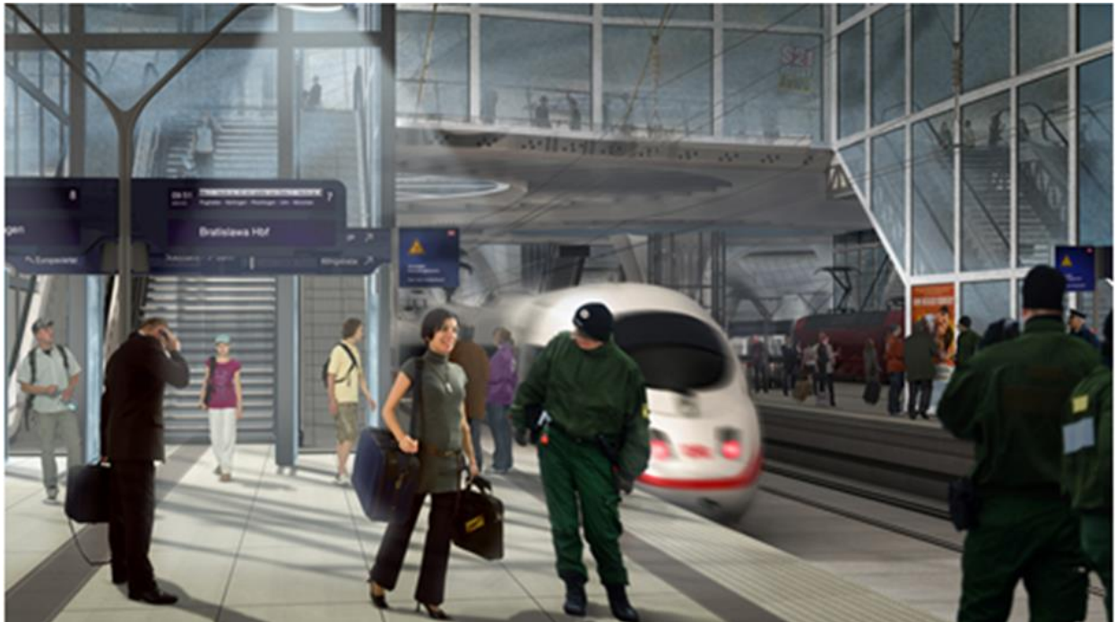
Abb. 3.2.2: S21-Tiefbahnsteighalle mit Brandschottung der Aufgänge und Querstege
