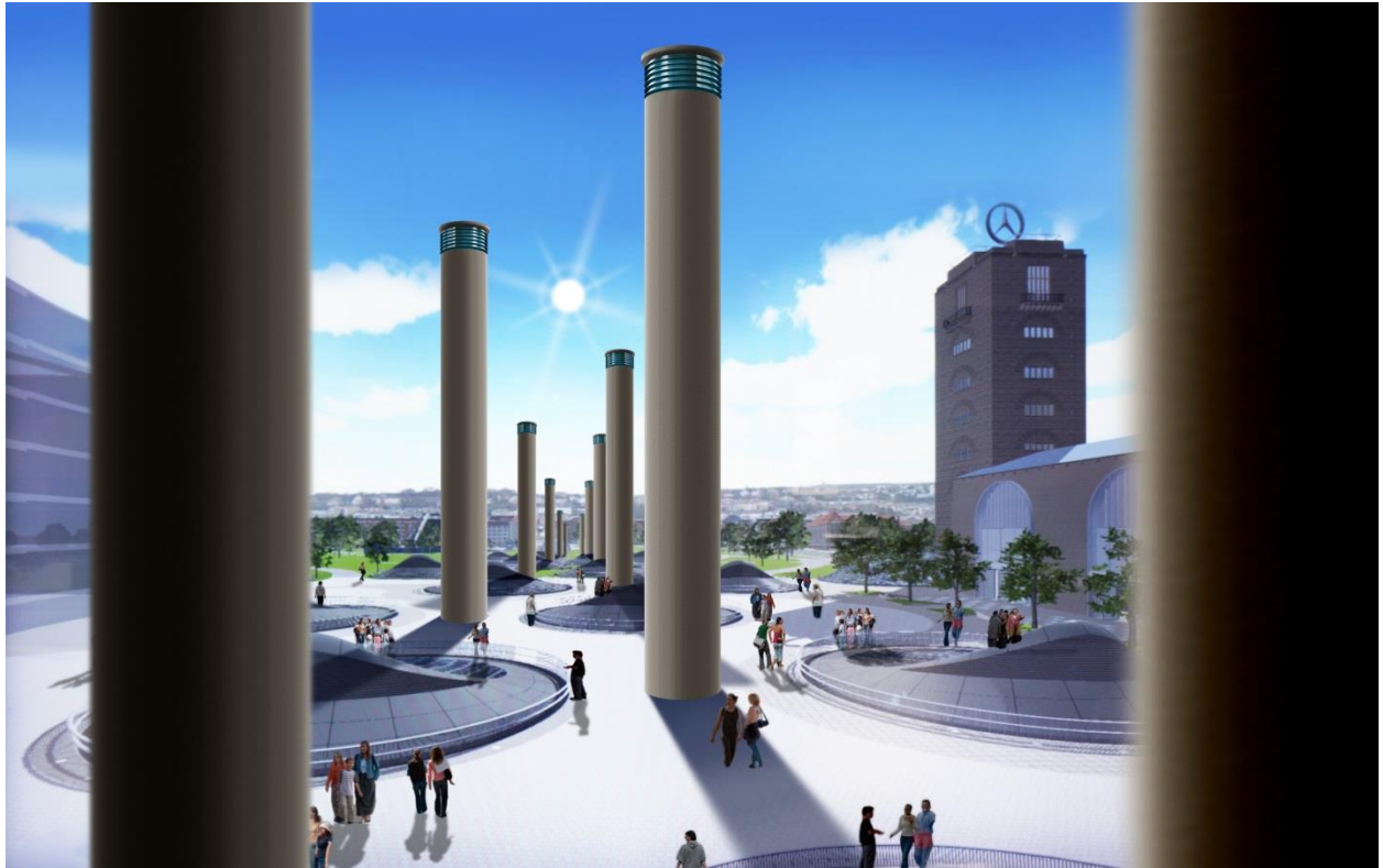
Abb. 7.9.1 Straßburger Platz: Absaugschächte zur Entrauchung Tiefbahnsteighalle
