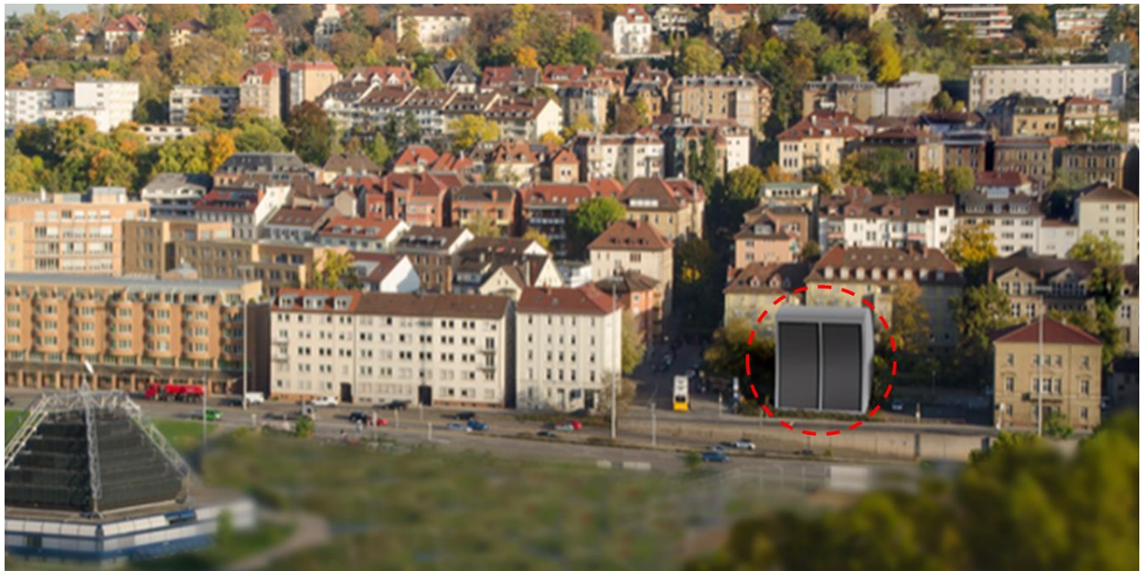
Abb. 8.1.1 Luftansaughutze Schwallbauwerk Süd zur Entrauchung Tiefbahnsteighalle
