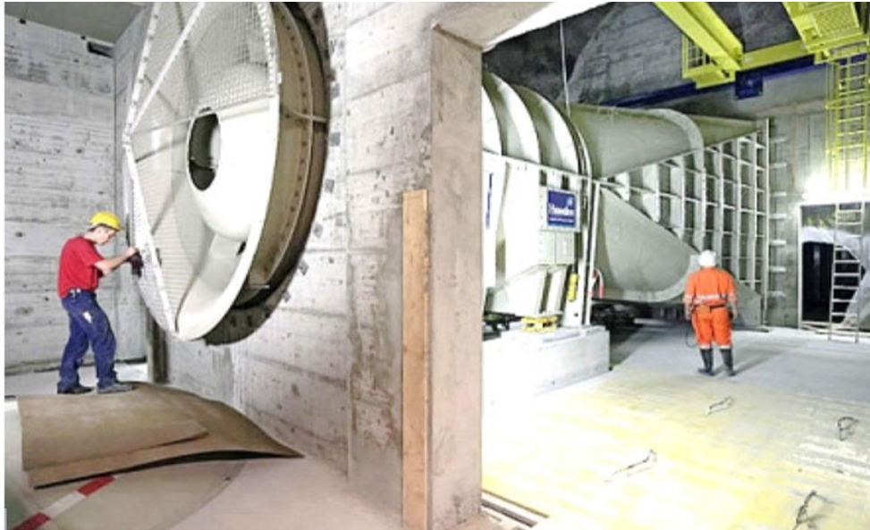
Abb. 8.3.1 Beispiel: Axial-Großgebläse [vorgestellt von Hr. Bieger / DB PSU auf UTA-Sitzung des Stuttgarter Gemeinderates am 16.2.2016]
