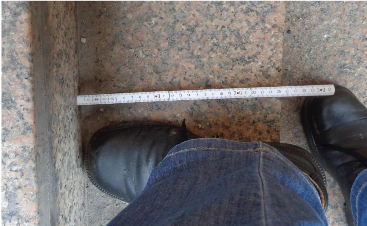
Abb. 3.3.2 Treppenstufe mit zu geringer Auftrittsbreite 26 cm
