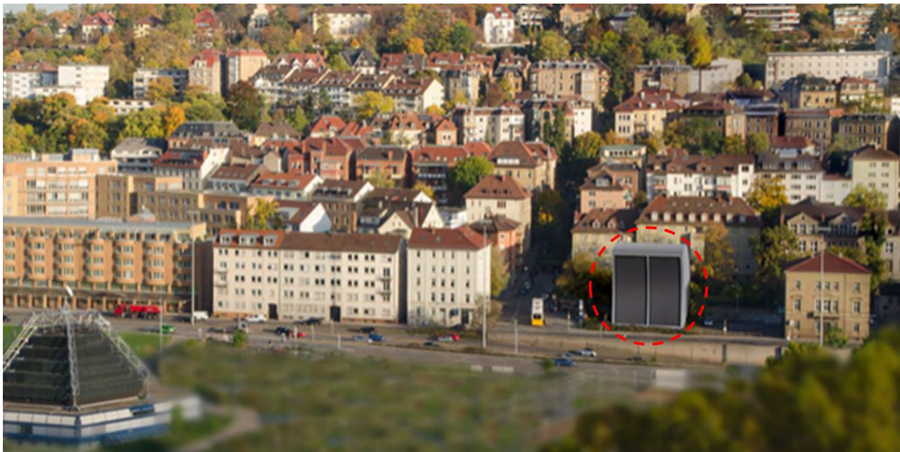
Abb. 6.1.1 Luftansaughutze Schwallbauwerk Süd z. Entrauchung Tiefbahnsteighalle
