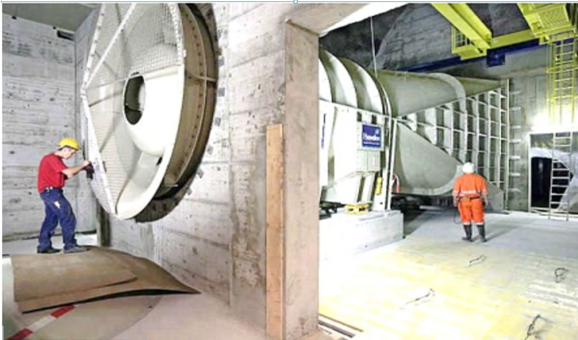
Abb. 6.3.1 Beispiel: Axial-Großgebläse [vorgestellt von Hr. Bieger/DB PSU auf UTA-Sitzung des Stuttgarter Gemeinderates am 16.2.2016]
